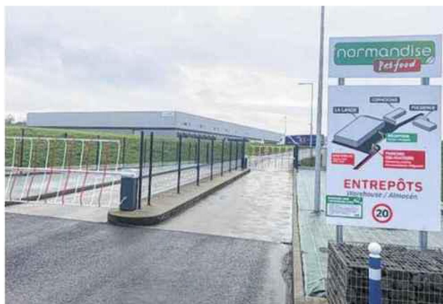
La plateforme logistique, route de Caen, va s'agrandir également d'un tiers.
