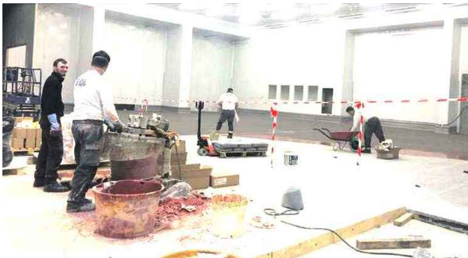
Sur le site de l'Allière, à Vire, une nouvelle salle de quelque 800 m 2 est en réalisation. Une fois les travaux terminés (en janvier prochain), 500 pochons y seront réalisés à la minute.
